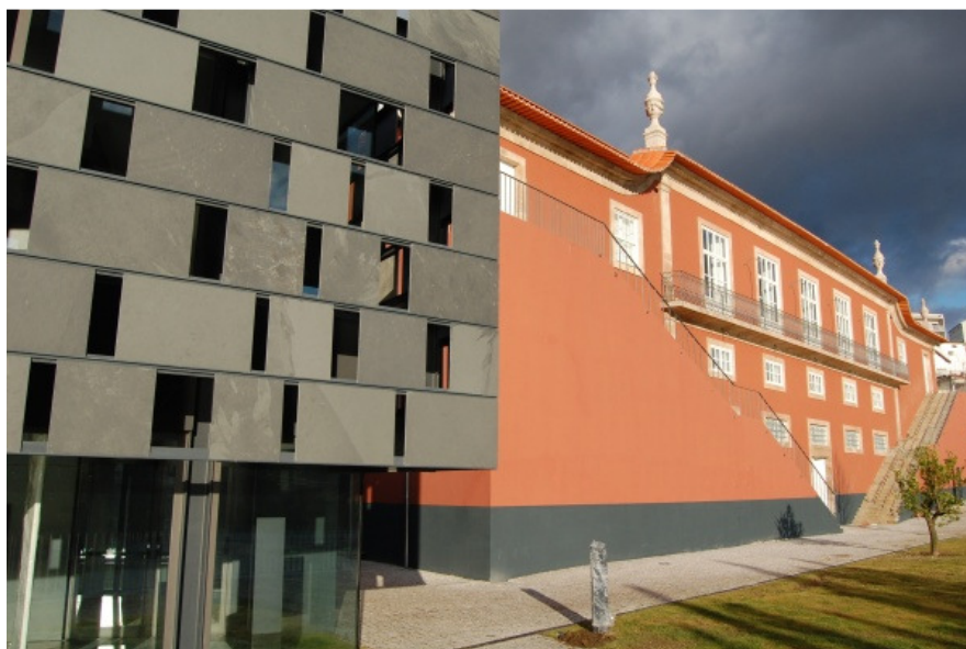
Edifício sede do Museu do Douro.
